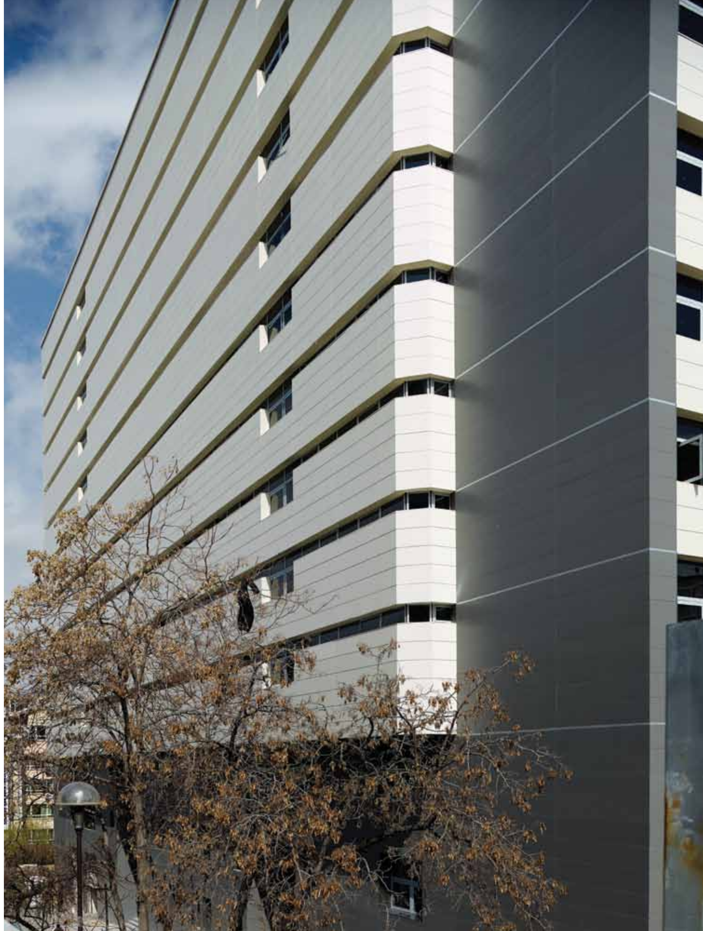
Çankaya Belediye Başkanlığı , Çankaya / Ankara — Gizli Klips Sistem Çankaya Municipality, Çankaya / Ankara — Hidden Clips Fitted Facade System
